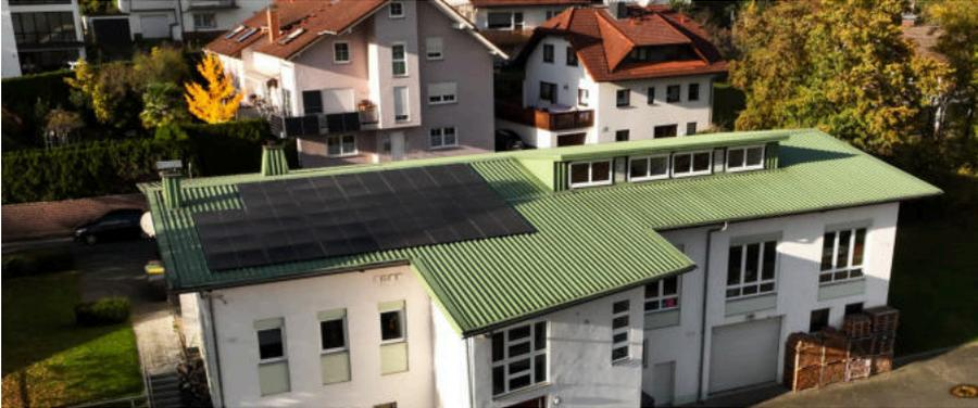
Das Vereinsheim des WCV hat sich fit fürs Sonnenzeitalter gemacht: 34 Solarmodule auf dem Dach liefern seit Mitte Oktober Strom mit einer Leistung von bis zu 15,3 Kilowatt.
